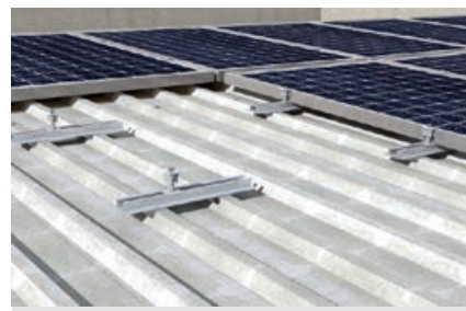
Instalación en cubierta con perfil pre-cortado de 400mm
