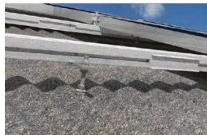
Detalle: tornillo STSI con unión SSP
