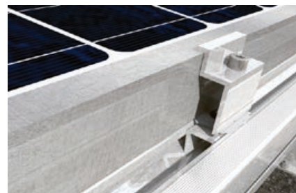
Detalle de la fijación de paneles fotovoltaicos
