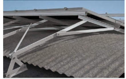
Detalle: vista posterior de la estructura
