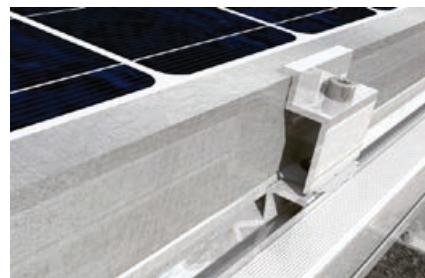
Detalle de la fijación de paneles fotovoltaicos
