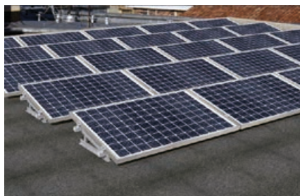
Cubierta plana sin muro perimetral
