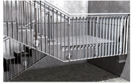
Gran carga en hormigón
