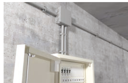
Fijación de tubos
