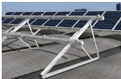
Instalación en cubierta industrial
