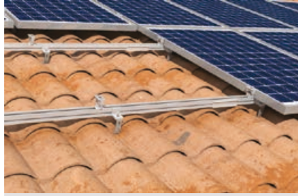
Detalle: Posicionamiento de las abrazaderas
