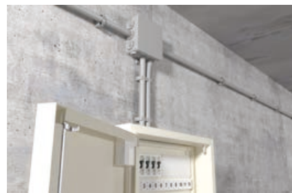
Fijación de tubos
