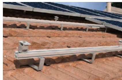
Detalle: Perfil solar-light
