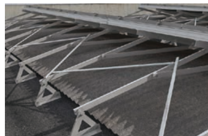
Detalle: vista de detalle del refuerzo
