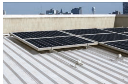
Instalación en cubierta industrial
