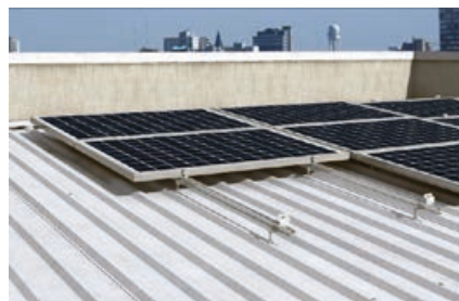
Instalación en cubierta industrial
