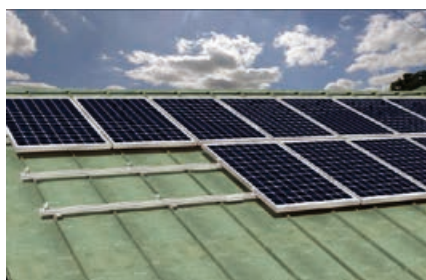
Cubierta con chapa grapada
