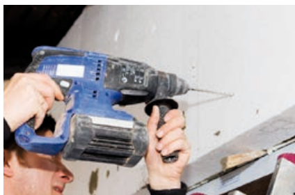
Perforación en estructura
