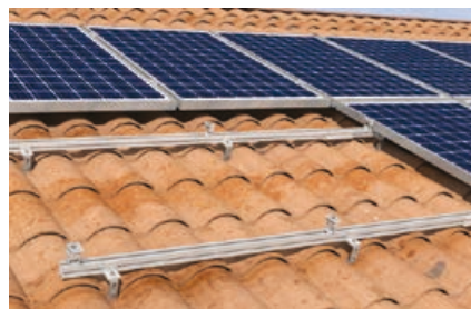
Detalle: Posicionamiento de las abrazaderas
