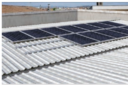
Cubierta industrial en chapa grecada
