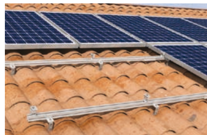
Detalle: Posicionamiento de las abrazaderas
