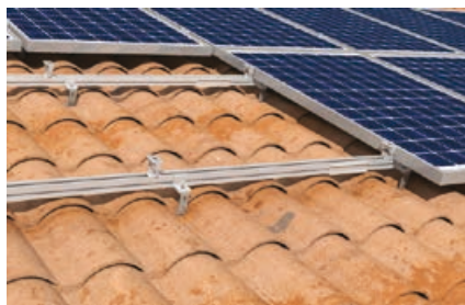
Detalle: Posicionamiento de las abrazaderas
