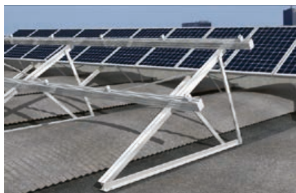
Instalación en cubierta industrial
