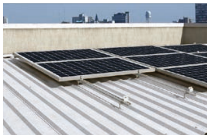
Estructura especial chapa grecada
