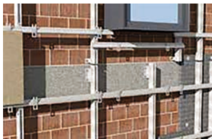
Montantes y travesaños de la subestructura
