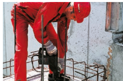
Perforación en hormigón
