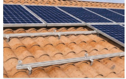
Detalle: Posicionamiento de las abrazaderas
