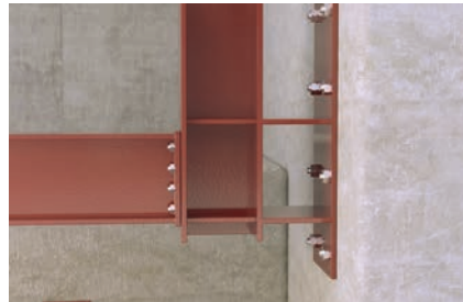
Vigas de acero
