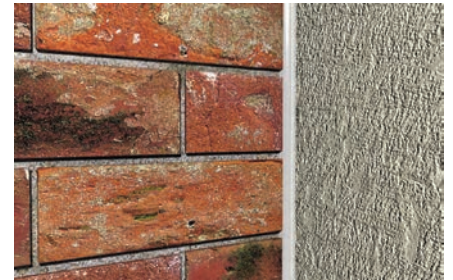
Aplicación en juntas de construcción verticales
