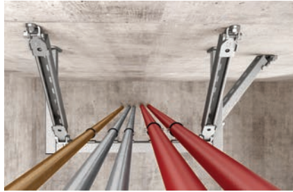
Arriostamiento de la construcción de marcos con perfiles de carril
