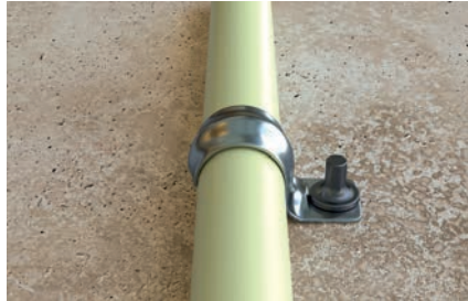
Fijación de conductos blindados
