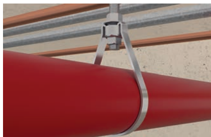
Instalación de tubería de rociadores
