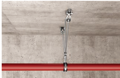
Arriostramiento de tubería con varillas roscadas
