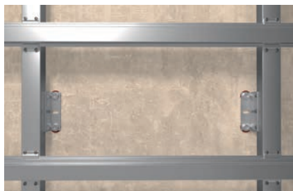
Subestructuras de fachada
