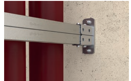
Voladizo con base de ménsula
