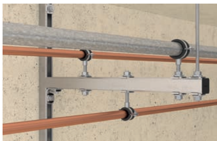
Montaje en voladizo con carril
