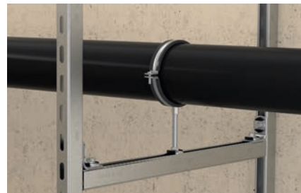
Fijación de tuberías en bastidor de carriles.
