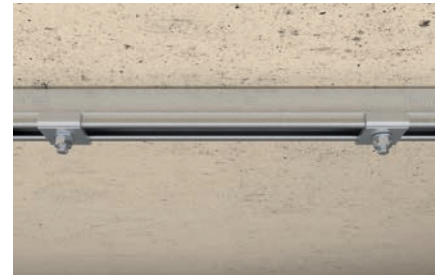
Instalación de carril en la pared
