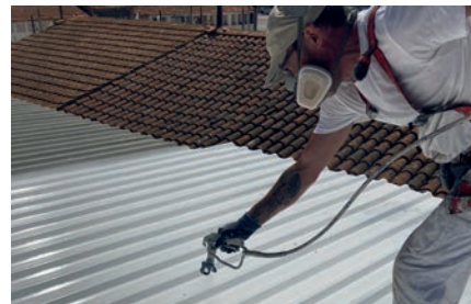
Aplicación en cubierta Industrial
