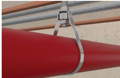
Instalación de tubería de rociadores
