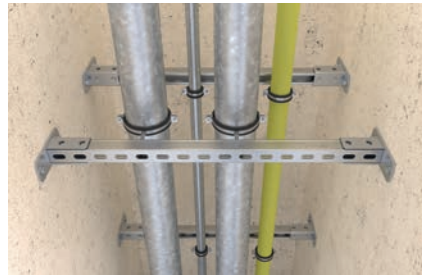
Instalación de tuberías en ruta de escape
