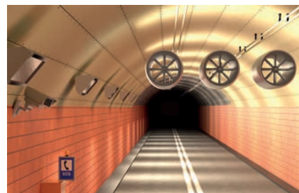
Paneles de protección contra incendios
