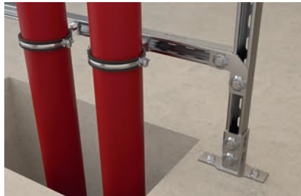
Tubería de aguas residuales
