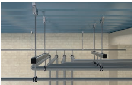
Tuberías suspendidas en techo trapezoidal
