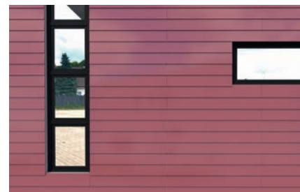
Subestructuras de fachada
