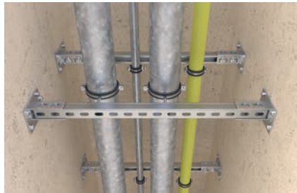
Instalación de tuberías en ruta de escape
