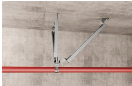
Instalación de tuberías con abrazadera para tuberías sísmicas
