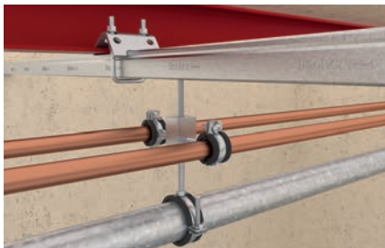
Instalación de tuberías regulables en altura.
