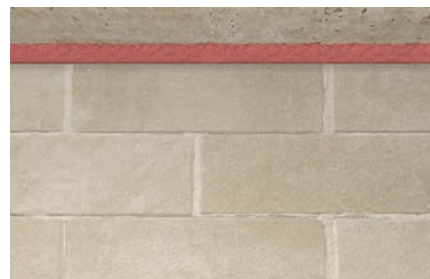
Aplicación en juntas de construcción
