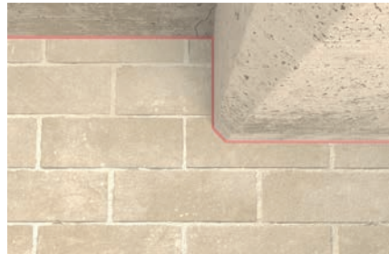
Aplicación en juntas de construcción
