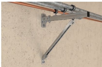
Instalación de peso pesado en voladizo
