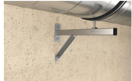
Fijación del tubo de ventilación a la pared.
