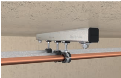
Fijación de tuberías en el carril de montaje
