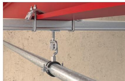
Canal a viga de acero
